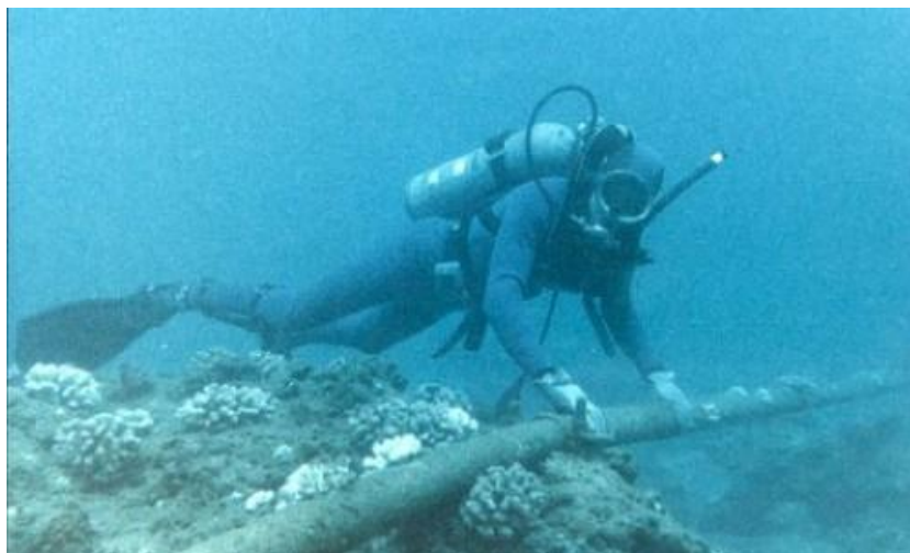
Slika 4 Primjer polaganja (sidrenja) kabela telekomunikacijske infrastrukture na dno mora
