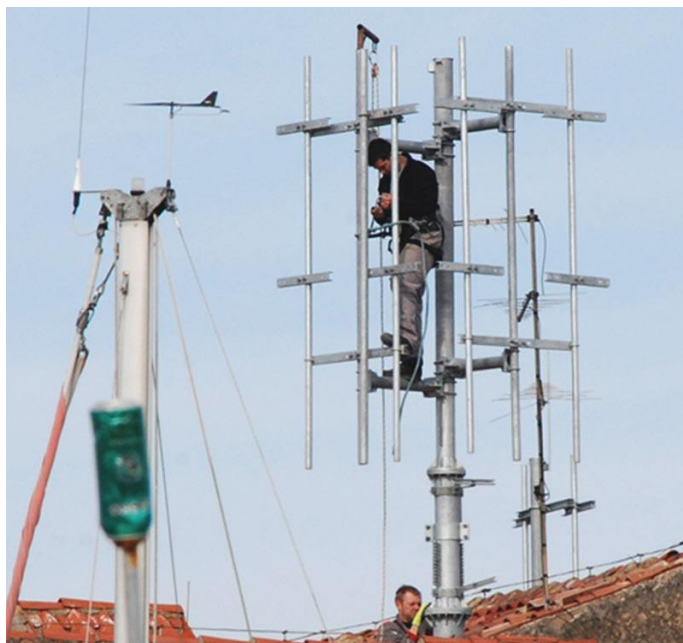
Slika 7 Primjer br. 2 uspostave bežične veze točka-točka koja podrazumijeva postavljanje antena na postojeći ili novi stup
