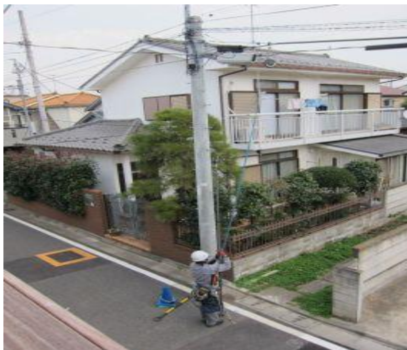
Slika 5 Primjer postavljanja svjetlovodnih kabela putem nadzemne mreže
