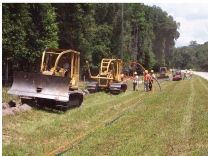
Slika 1 Primjer br. 1 kopnenih građevinskih radova
